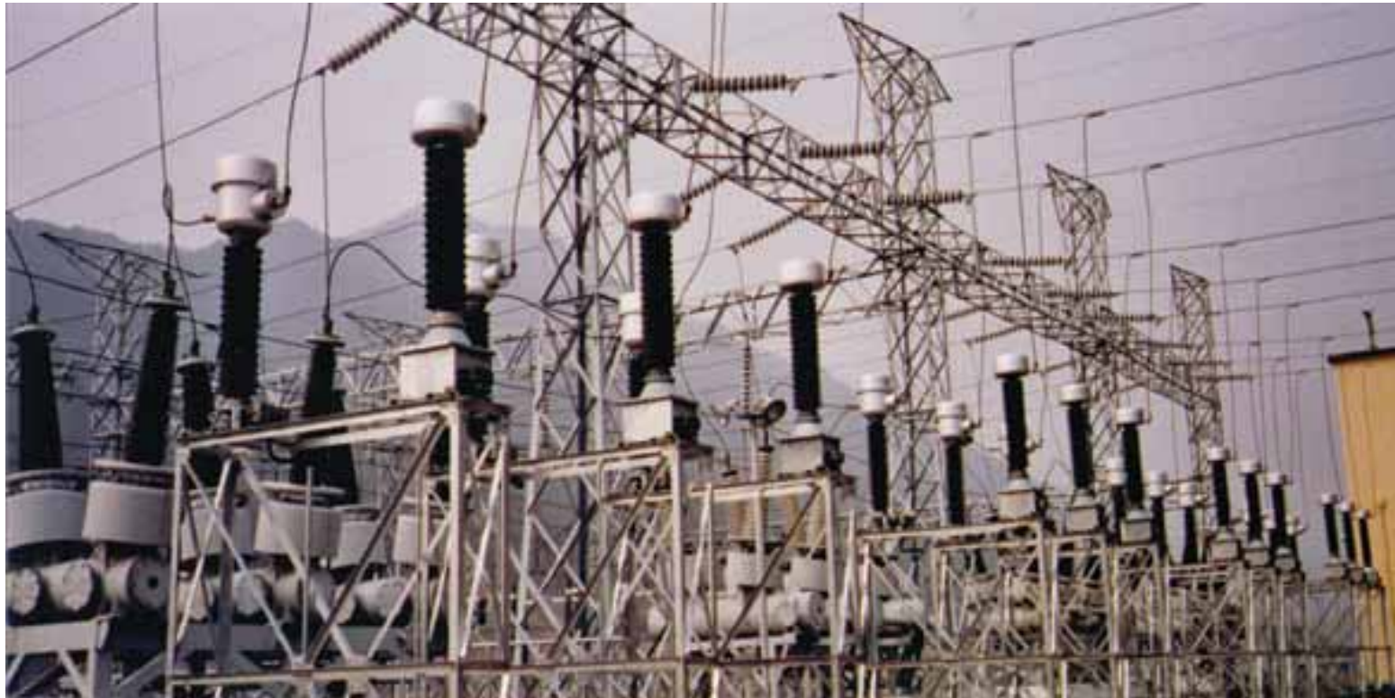
Transformadores de Intensidad y de Tensión Inductivos de 145 kV para zonas de gran altitud
