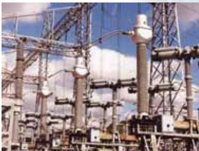
Transformadores de Intensidad de 362 kV de medida y protección. Louisville Gas & Electric (USA).
