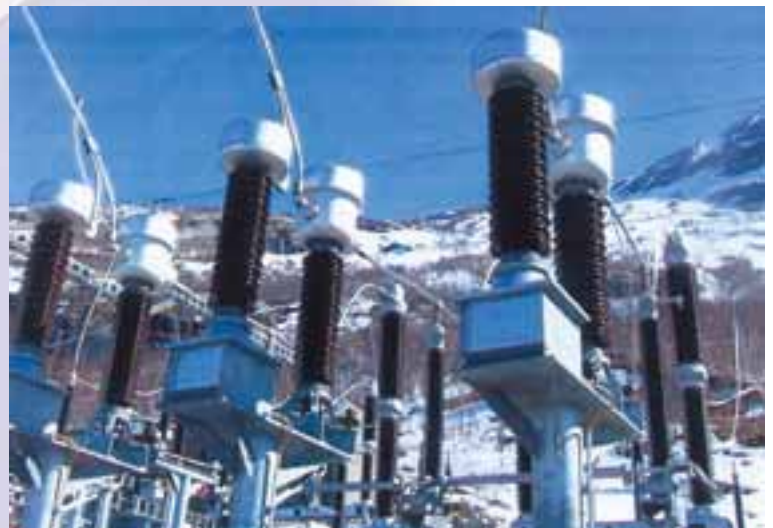
Transformadores de Intensidad y de Tensión Inductivos de 145 kV en condiciones climáticas extremas. Salten Kraftsamband (Noruega).
