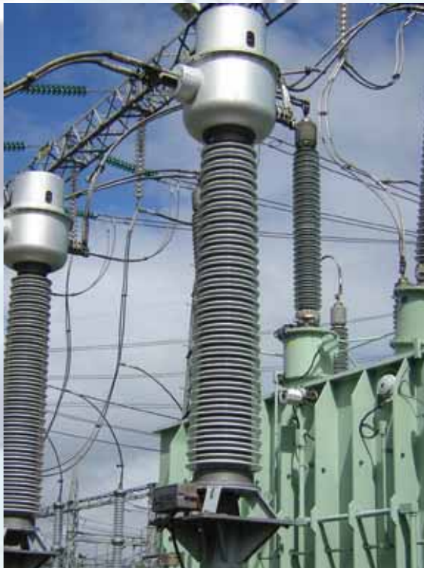
Transformadores de Intensidad de 245 kV con diseño especial antisísmico. Transpower (Nueva Zelanda).
