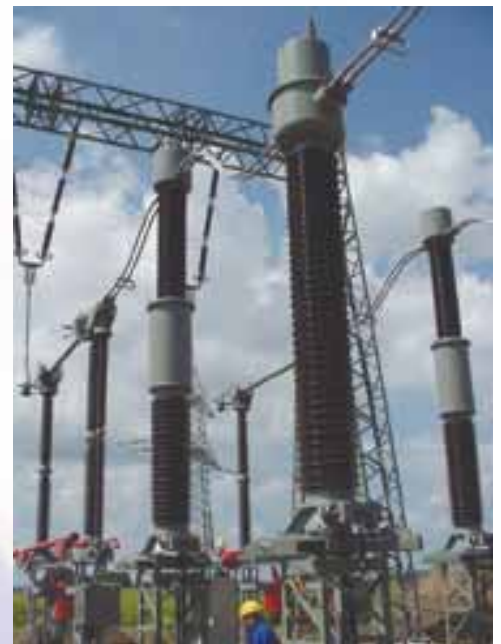
Transformadores de Intensidad y de Tensión Inductivos de 420 kV en entrada de línea de subestación. Vattenfall Transmission (Alemania).
