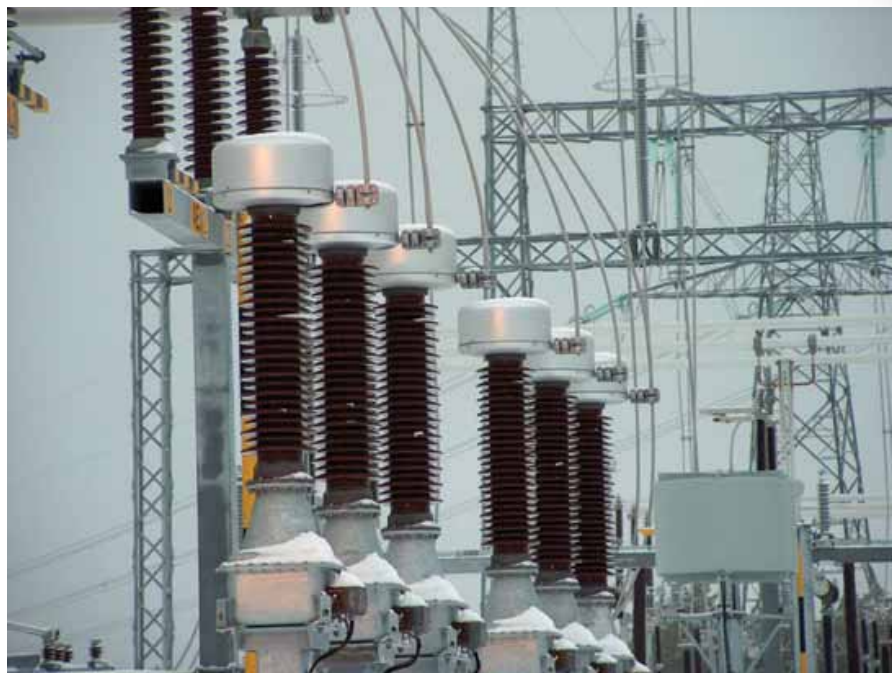
Transformadores de Tensión Inductivos de 123 kV. Fingrid (Finlandia).
