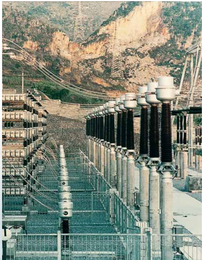
Transformadores de Intensidad de 245 y 123 kV en interconexión de corriente continua (H.V.D.C.). Diseñada por Siemens Alemania para State Power South Co. (China)
