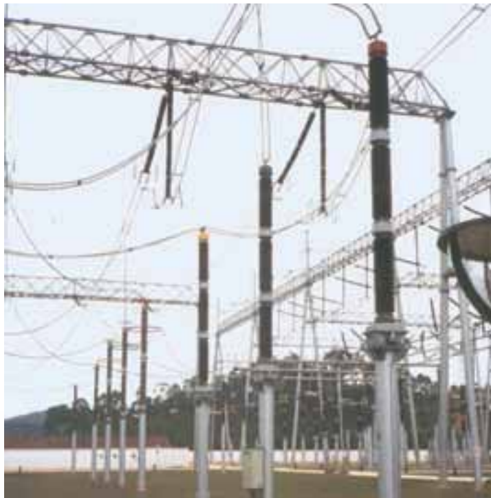
Transformadores de Tensión Capacitivos de 550 kV en interconexión de corriente continua (H.V.D.C.) Diseñada por Siemens Alemania para State Power South Company. (China)
