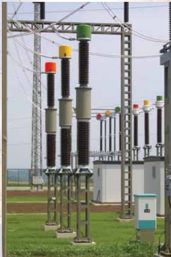
Transformadores de Tensión Inductivos de 420 kV MVM (Hungría).
