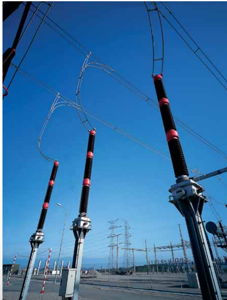
Transformadores de Tensión Capacitivos de 400 kV. Red Eléctrica Española (España)
