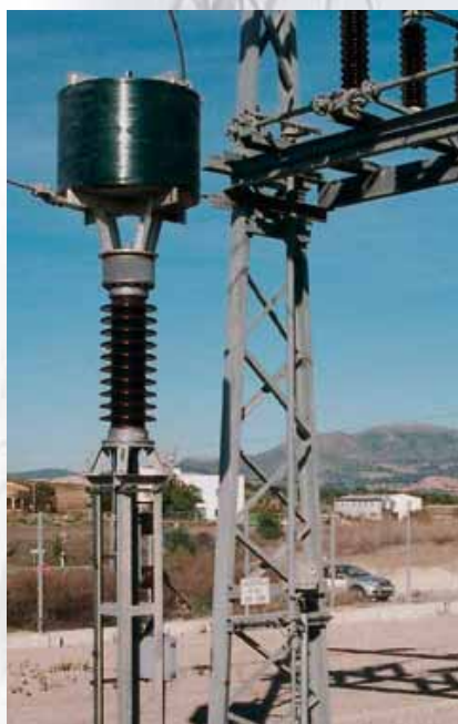
Bobina de Bloqueo en montaje tipo pedestal sobre Condensador de Acoplamiento de 72 kV. Endesa (España).
