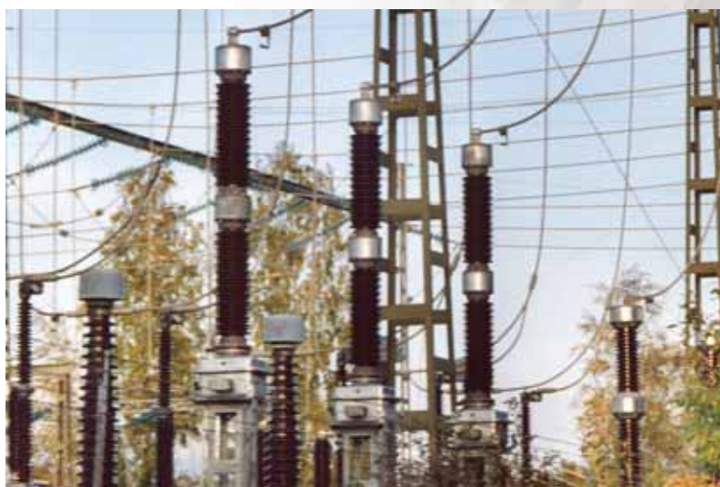
Transformadores de Tensión Capacitivos de 245 kV. Svenska Kraftnät (Suecia).
