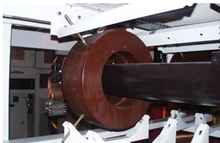
ABG - 24 Transformadores para generación diseñados para soportar altas temperaturas de servicio.
