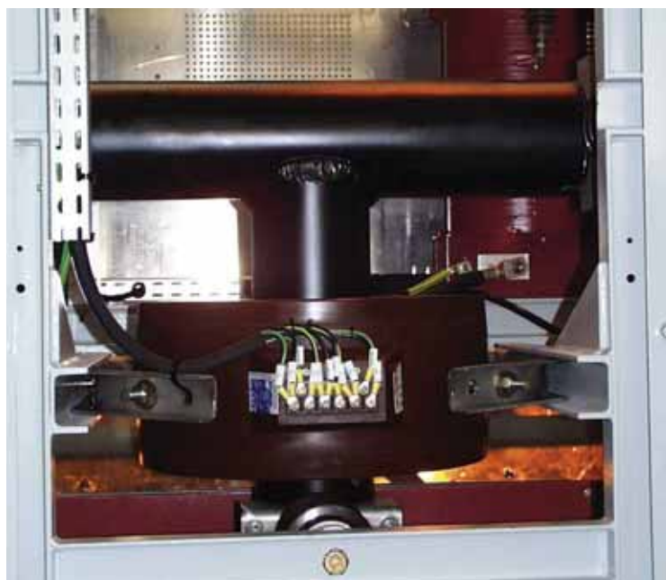
ABF - 24 Transformador para aplicación a salidas de generación.
