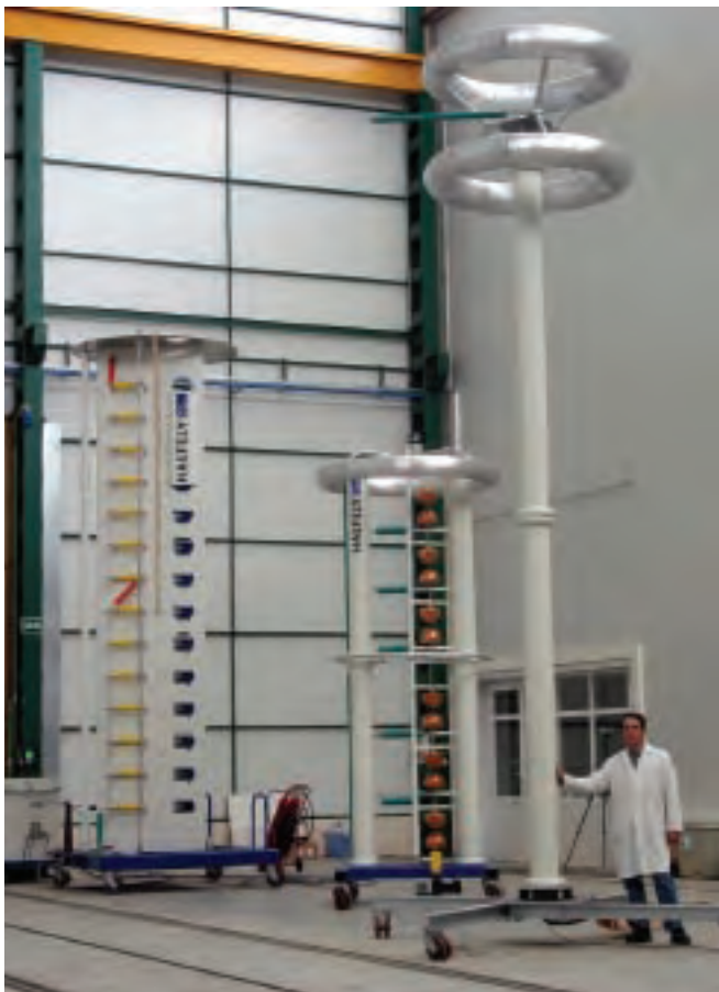
Generador de impulso, espinterómetro y divisor para ensayos con onda plena y cortada Impulse Generator, spark-gap and divider for tests with impulse full and chopped on the tail
