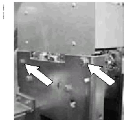
Retirar los 2 tornillos de fijación de la parte trasera del soporte del relé.
