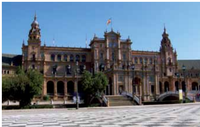
Praça de Espanha. Sevilla (Pára-raios com dispositivo de ionização)
