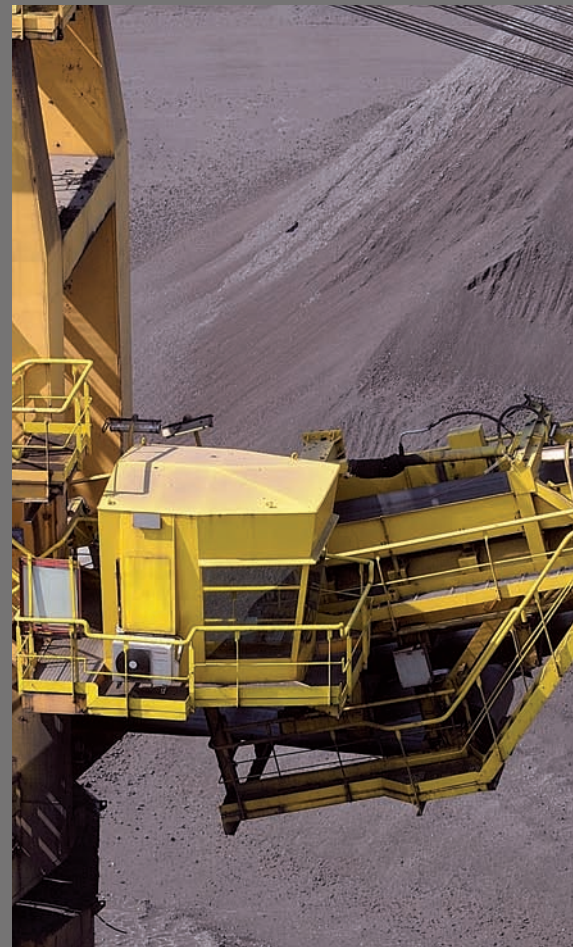
ARCELORMITTAL, DUNKERQUE/FRANCE – EXCAVATRICE À GODETS ARCELORMITTAL, DUNKIRK/FRANCE – MULTI-BUCKET EXCAVATOR
