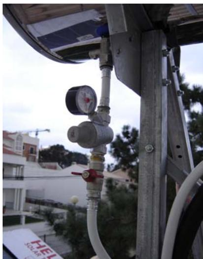
A aplicação da Válvula de segurança deve-se à necessidade de regular as oscilações de pressão da água da rede à entrada do circuito secundário do depósito
