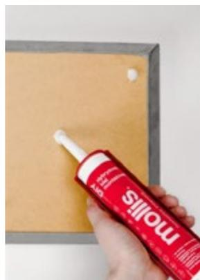
Montagem: Aperte o adesivo com uma pistola de montagem e aplique em vários pontos, pressione levemente e ...terminou.
