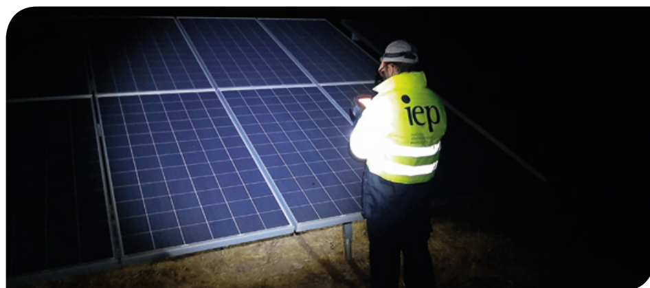
Figura 1 Identificação de strings desligadas em coberturas sem acessibilidade permanente.
